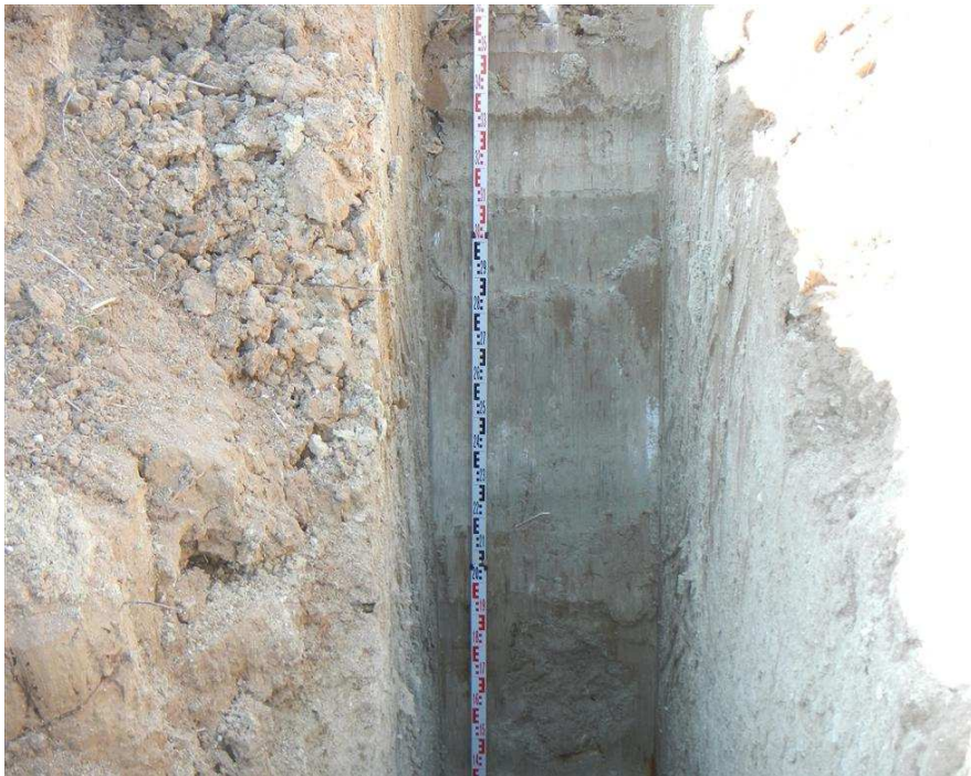
Foto-Nr. 12: Schurf U 6, mittlerer und oberer Abschnitt der Schurfgrube
