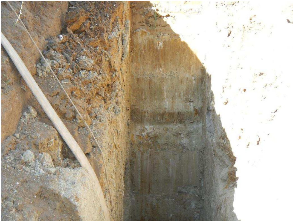
Foto-Nr. 4: Schurf U 2, mittlerer und oberer Abschnitt der Schurfgrube
