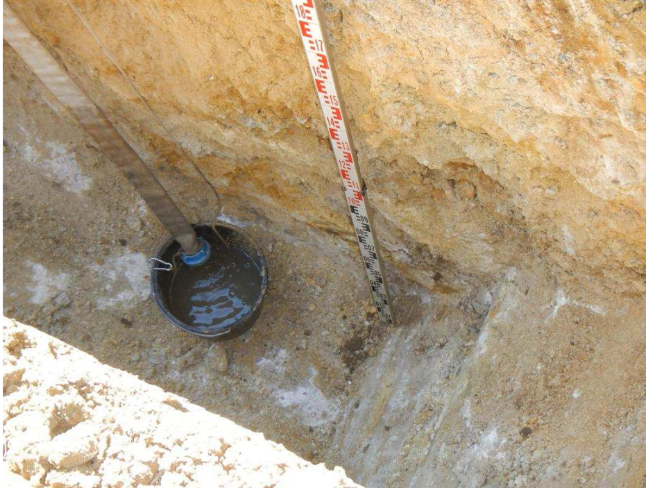
Foto-Nr. 5: Schurf U 3, unterer und mittlerer Abschnitt der Schurfgrube
