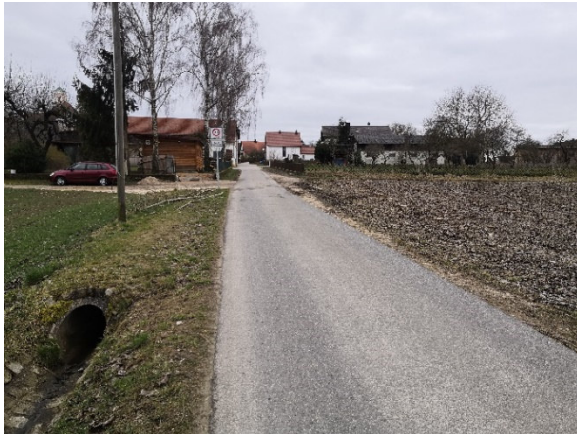
Blick von der Straße nach Thalhof Richtung Norden Links im Bild: Graben für Ableitung Regenwasser
