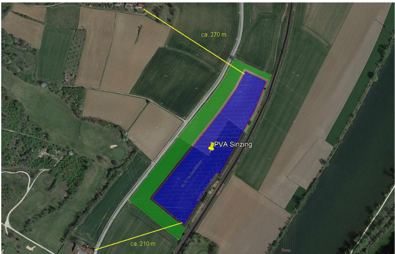
Bild 2.2.1: Gebäude im Nordwesten und Südwesten der PV Anlage (Quelle: Google Earth / SolPEG)
